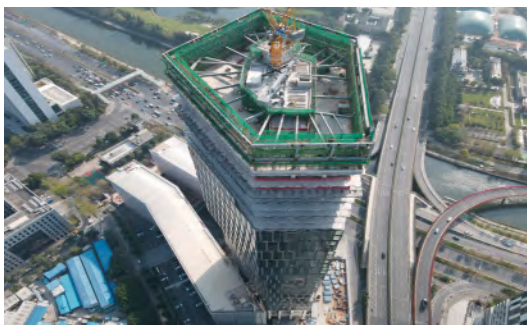
深圳金蝶云大厦幕墙项目
