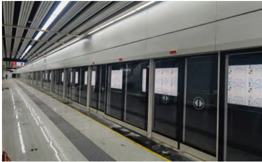
西安地铁 16 号线轨道交通屏蔽门项目
