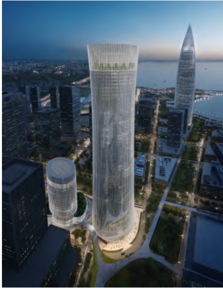
安邦财险深圳总部大厦幕墙项目
